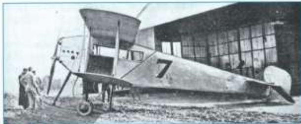
Figure 10. Avro G (1912), premier avion officiellement sorti de vrille sur une action de son pilote. On remarque une forme du fuselage relativement pure qui le rapproche de nos appareils modernes. Elle explique peut-être pourquoi, tout comme sur un CAP 10 l'action « pied opposé à la vrille » a été efficace pour en sortir.
